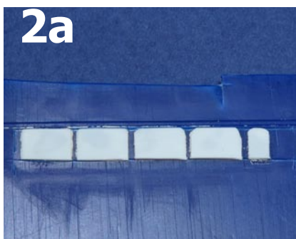
2 a/b/c. Na steny kabíny vyrobené polstrovanie jednoduchým postupom z olovenej fólie
